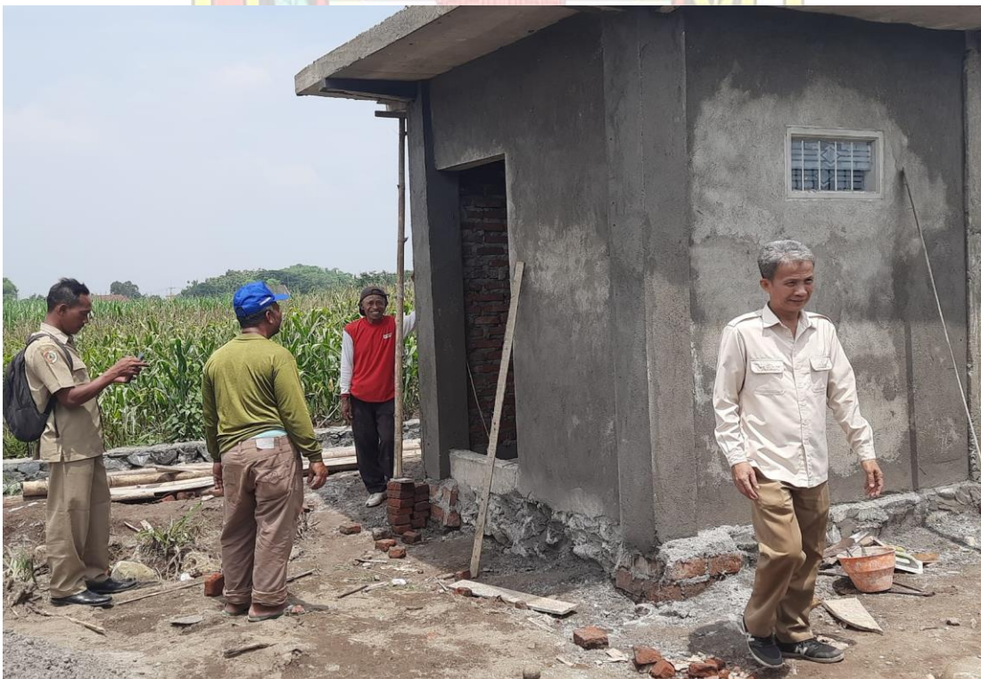
10. Kegiatan pembangunan irigasi perpompaan (APBD Provinsi Jatim)
