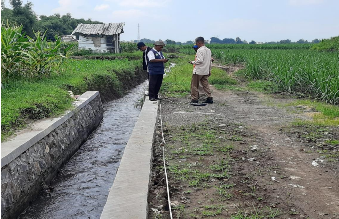
9. Pembangunan kegiatan Rehabilitasi Jaringan Irigasi Tersier (RJIT) APBN-Aspirasi
